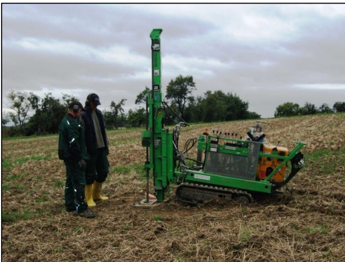
Bild 7"Bohrung zur Untersuchung des Altablagerrungskörper"
